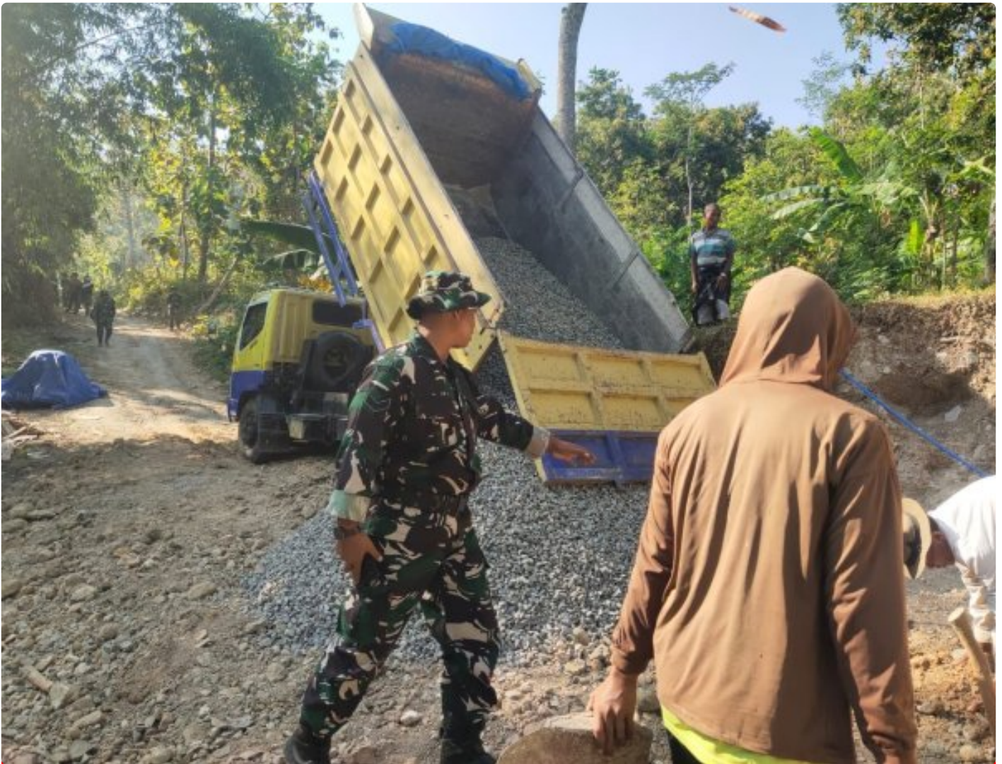
Foto: Saat Sertu Wiji selaku Babinsa anggota Koramil 08/Sluke Selalu Mengecek Setiap Material Yang Datang di Desa Labuhan Kidul, Kecamatan Sluke, Kabupaten Rembang, Jawa Tengah, Selasa (13/08/2024).
